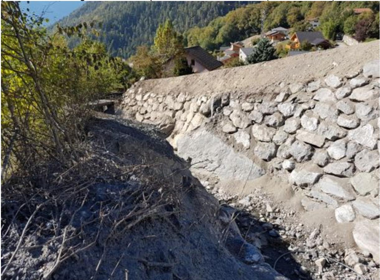
photo n°12. Détail des travaux réalisés après la lave torrentielle. dépôts laissés par la lave torrentielle. (Daniel Masotti)
